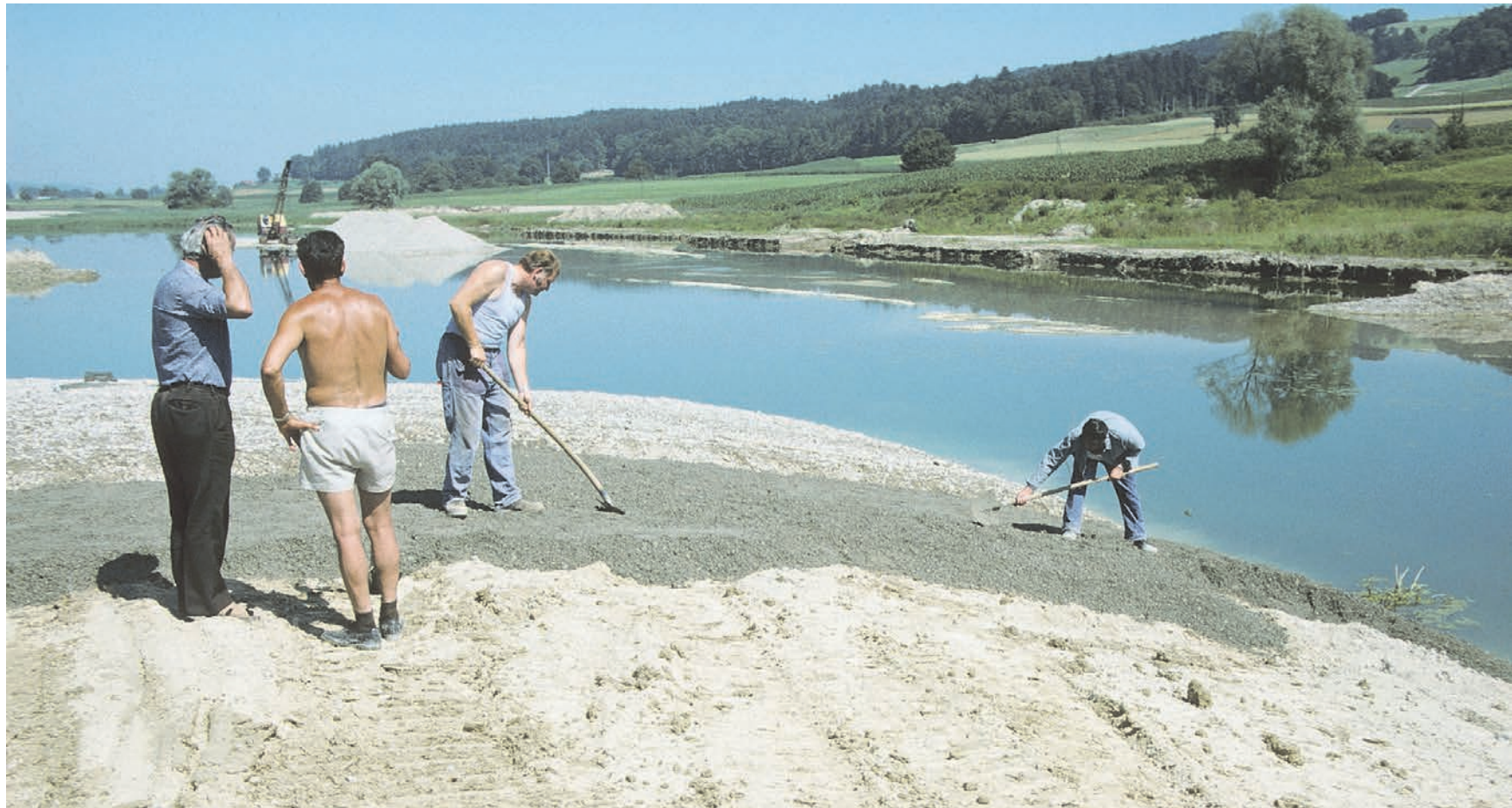
Die Inseln im Flachsee wurden betoniert.
