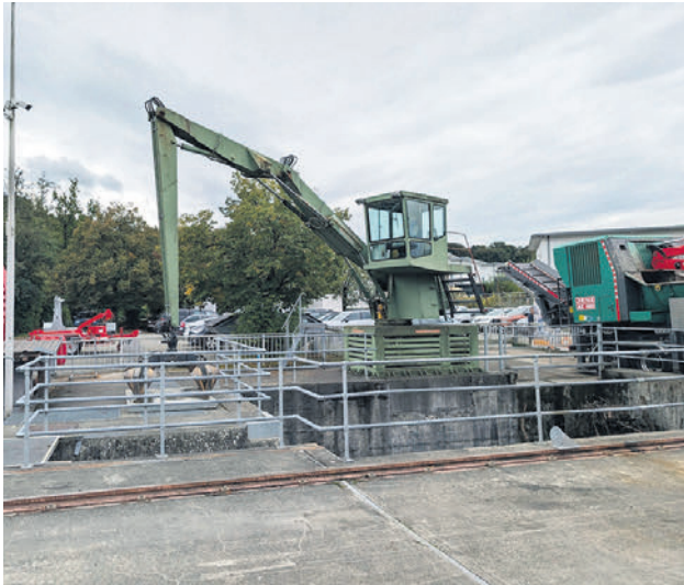
Die Reuss führt nicht nur Wasser, sondern auch viel Schwemmgut. Dieses wird hier tonnenweise aus dem Fluss gezogen.
