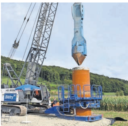
Bohrungen sind erfolgt.
