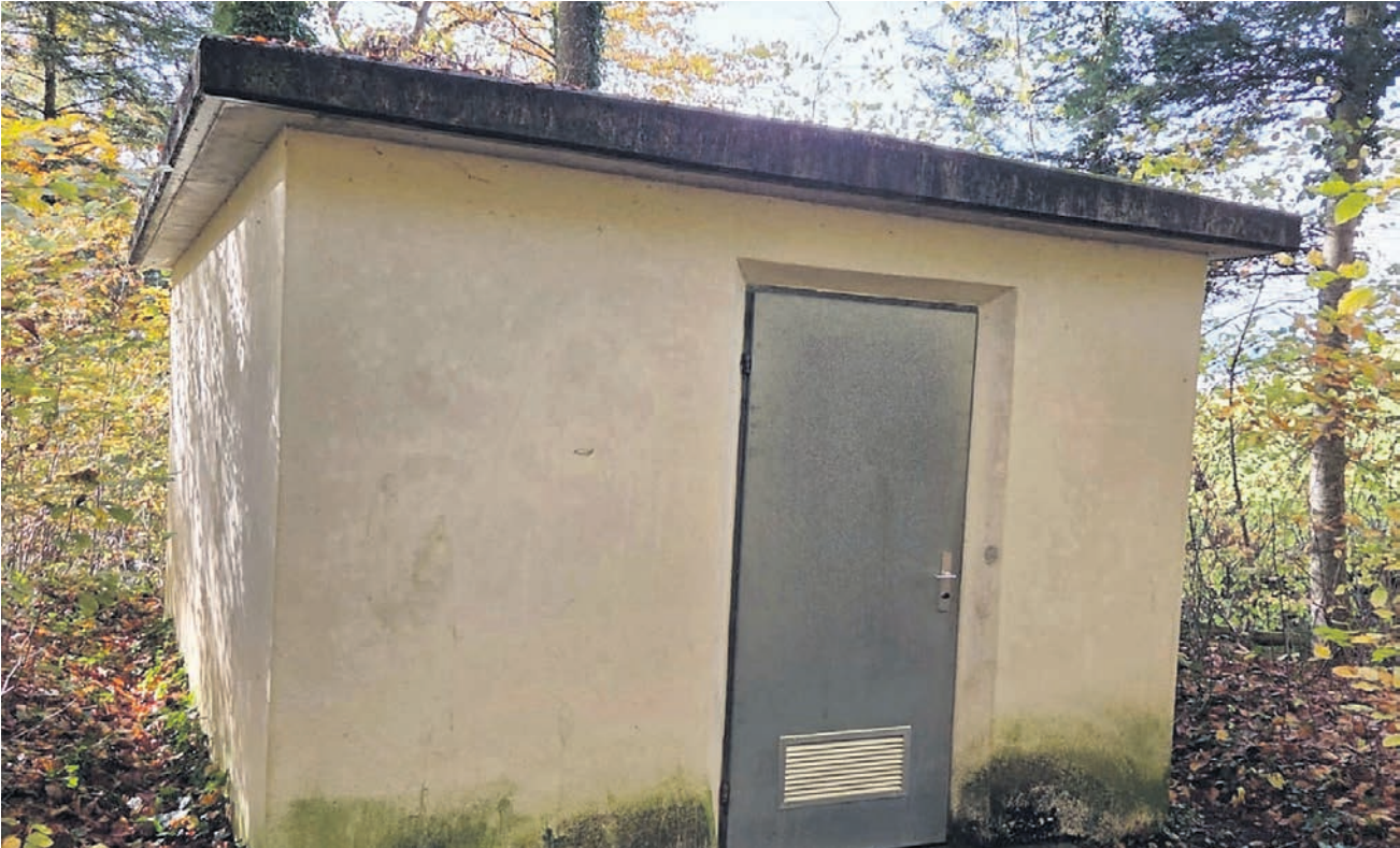
Dieses Häuschen des Quellwasserpumpwerks soll im Zuge der Sanierung abgerissen werden.
