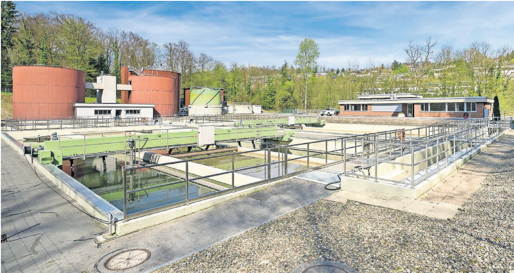
Die Bremgarter Kläranlage ist in die Jahre gekommen. Der notwendige Um- und Ausbau bietet auch Chancen für die Abwasserverbände.
