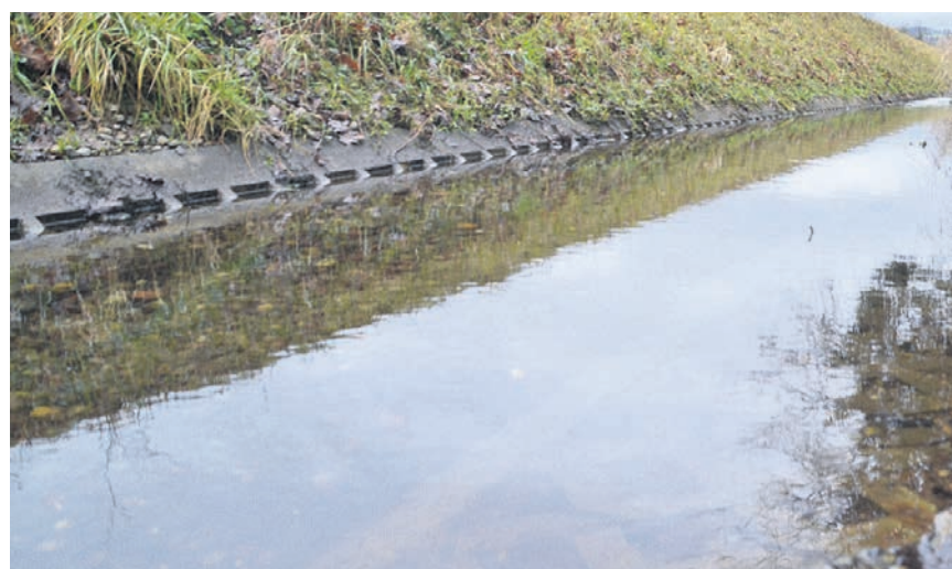
Der Girizkanal soll von seiner Beton-Gitterstein-Sohle befreit werden.
