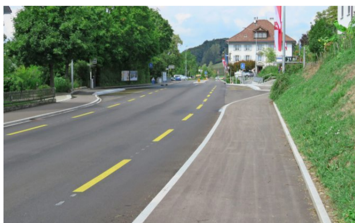
Die Sanierung der Kantonstrasse kommt Eggenwil etwas günstiger zu stehen als erwartet. Bild: Marc Ribolla (2022)
