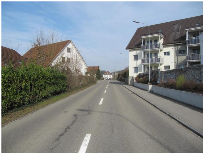
Querstellung der Häuser bei der Trottengasse 2
