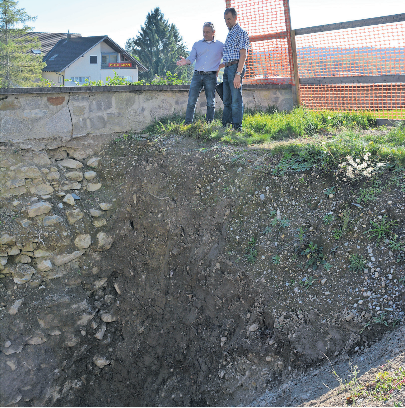
Marco Hasler (Architekt) und Franz Rutzer (Kirchgemeinde) schauen auf den Grund der Stützmauer.
