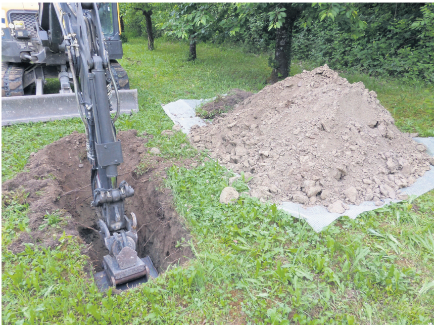
Mit Baggerschlitten wurde die Deponie untersucht.
