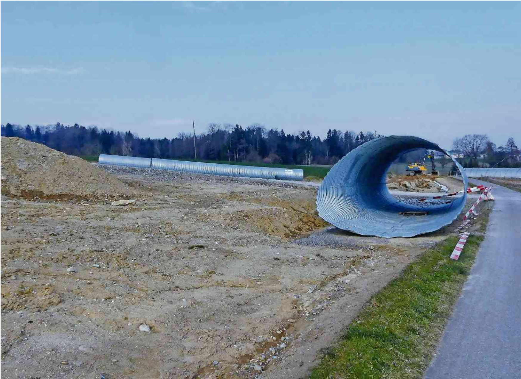
Die Bauarbeiten für die Aushubdeponie Babilon in Dietwil haben begonnen. Hier soll ab schon bald sauberes Aushubmaterial abgelagert werden.
