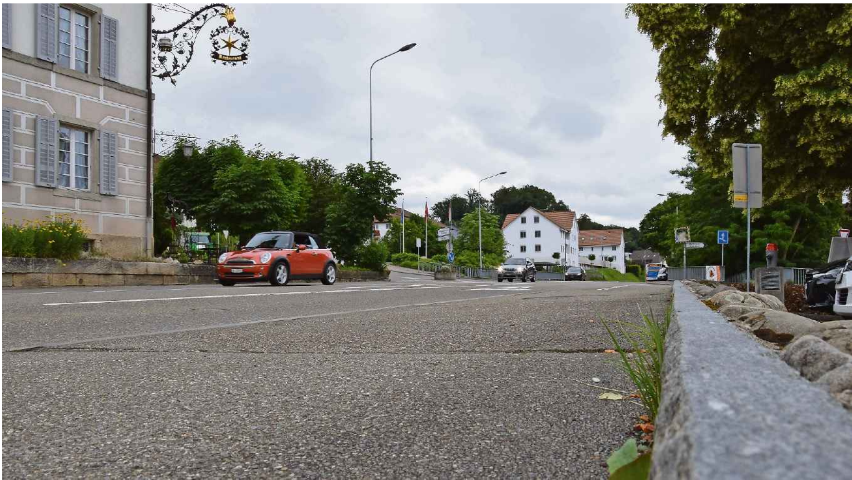
Die Badenerstrasse in Eggenwil soll saniert und begrünt werden, um dem Dorf Innerorts-Charakter zu geben.
