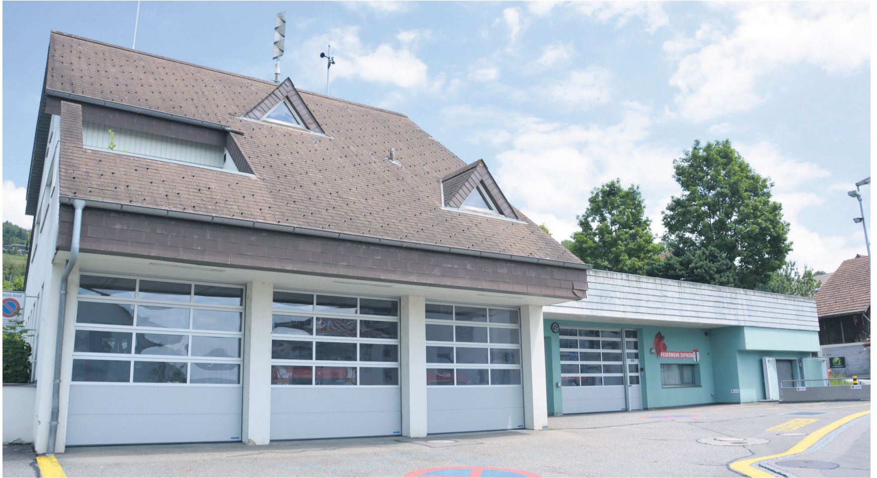
Die Holzschnitzelheizung im Mehrzweckgebäude muss bald saniert werden.
