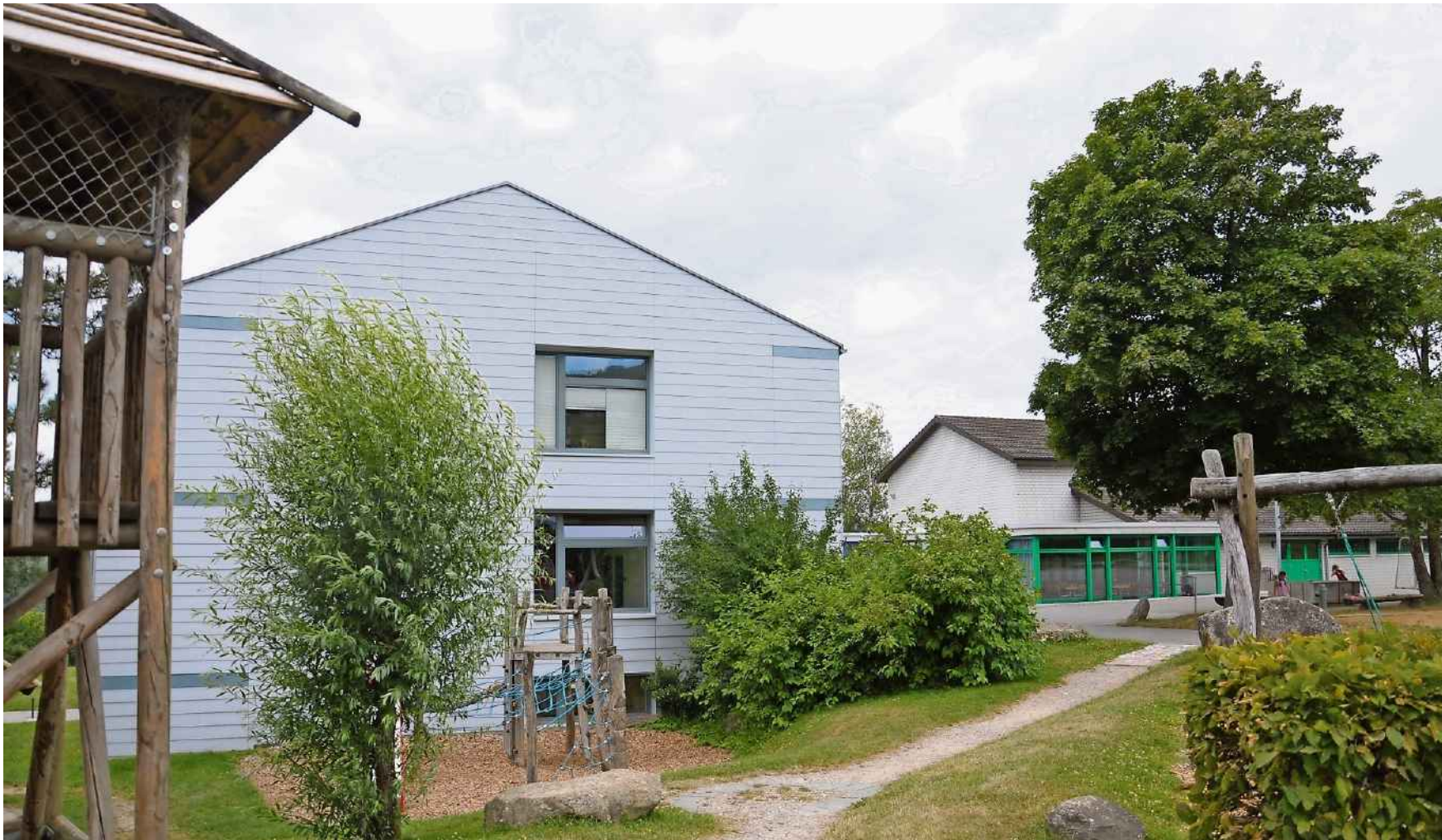
Schülerzahlen steigen weiter: Kaum saniert und ausgebaut, ist die Eggenwiler Schulanlage schon wieder zu klein.
