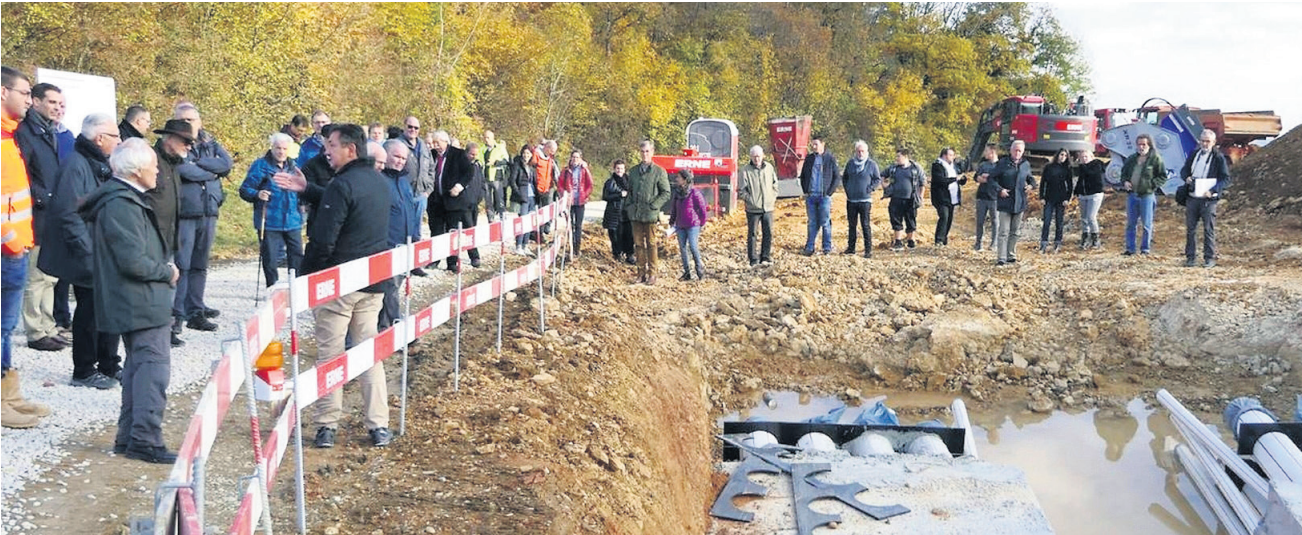
In Riniken wird die Hochspannungsleitung im Boden geführt. Das interessiert auch die Mitglieder des Vereins Verträgliche Stromleitung Reusstal.
