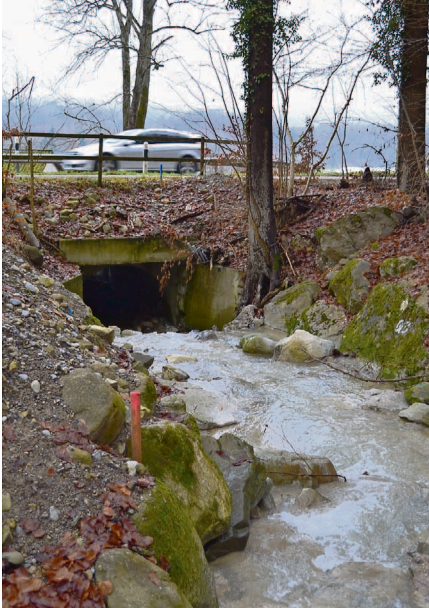
Neben dem alten Bachdurchlass (Foto) wird ein neuer Durchlass gebaut.
