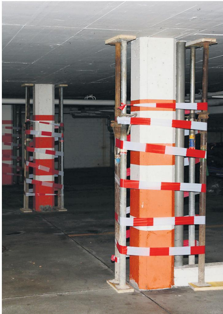
Damit die Deckenplatte nicht durchbricht bei den Stützen, wurden in allen drei Einstellhallen Spriessungen angebracht.
