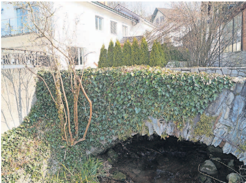
Anti-Überschwemmungs-Massnahme: Im Unterdorf werden die zwei Junebach-Brücklein abgebrochen und durch einen Kanal in Form eines Rechtecks ersetzt. SL
